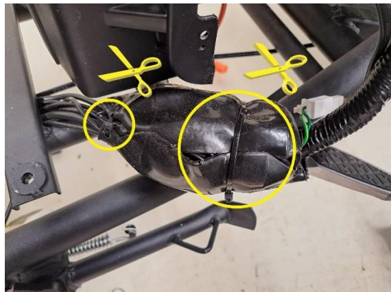
Katko johtosarjan liittimien suojaa kiinni pitävät nippusiteet (sivuleikkurit).
